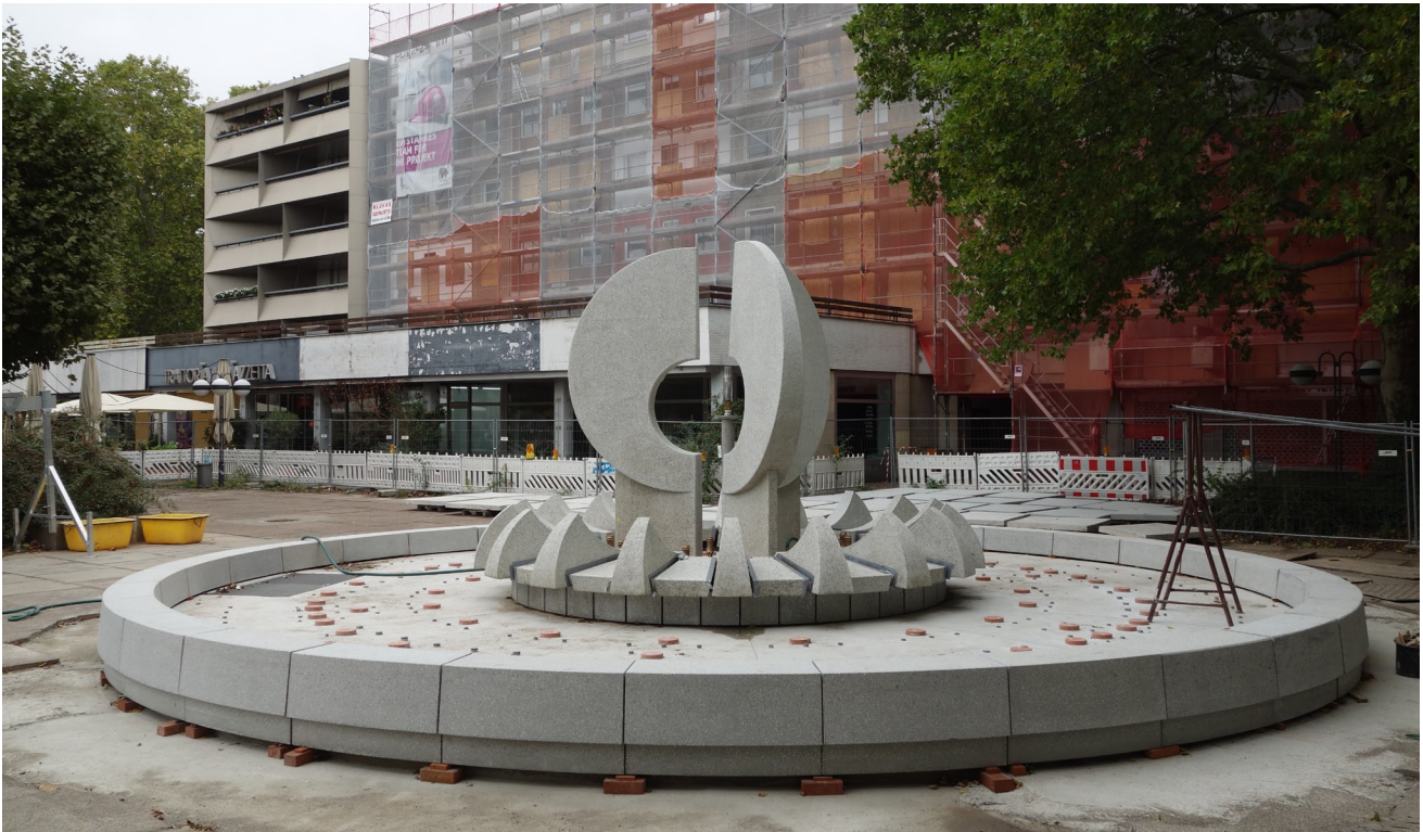
Trotz Verzögerungen schon Ende 2025 fertig: der östliche Krachtbrunnen. (Foto: JHP)
