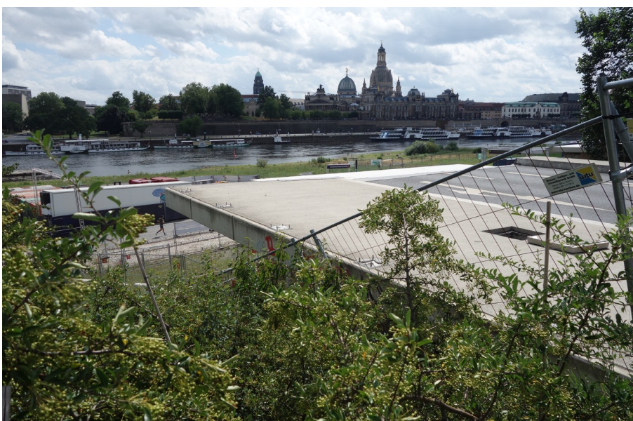
Der Wiederaufbau der Carolabrücke betrifft auch Fragen der städtebaulichen Entwicklung Dresdens. (Foto: JHP)
