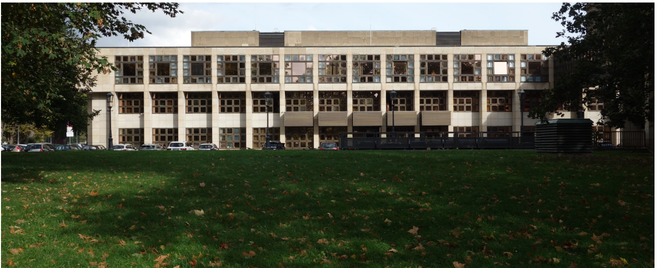
Vor dem baufälligen Funktionsgebäude der Semperoper entsteht das umstrittene Ballettzentrum. (Foto: JHP)
